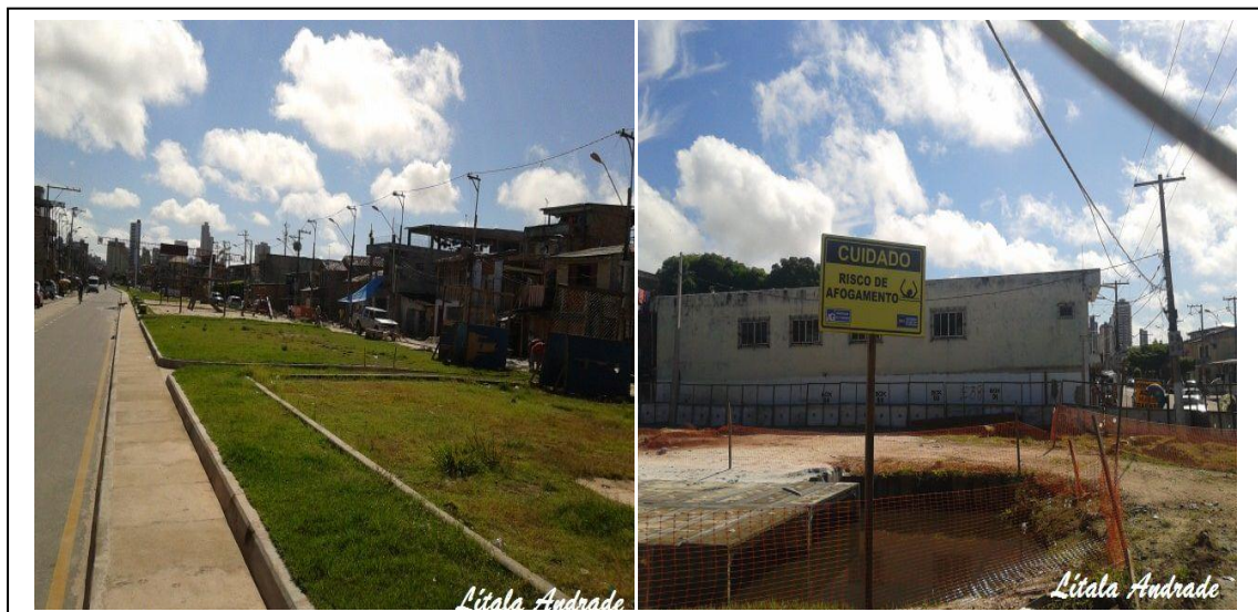
Figura 1 - Área da Macrodrenagem no Bairro do Jurunas
